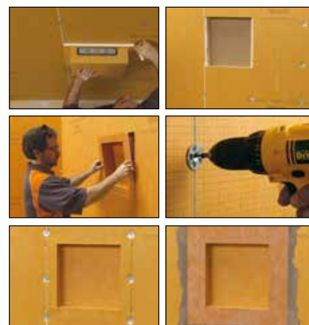
Einbau in KERDI-BOARD
