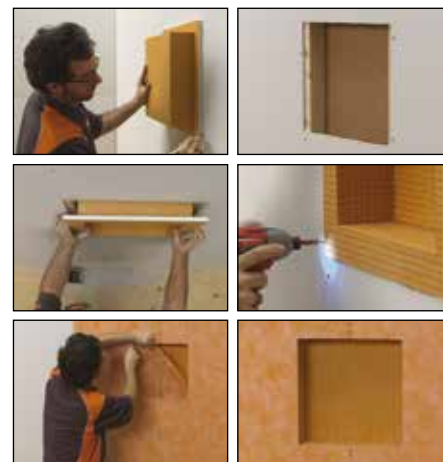
Einbau in Gipskarton
